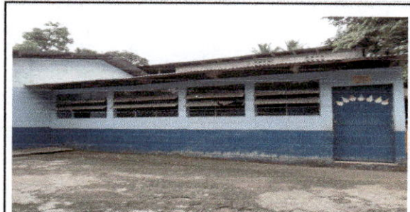
Foto 6: Sustitución de lámina, por lámina troquelada aluzinc calibre 26
