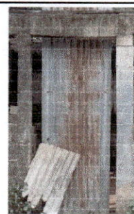
Foto 4: Sustitución de puerta
